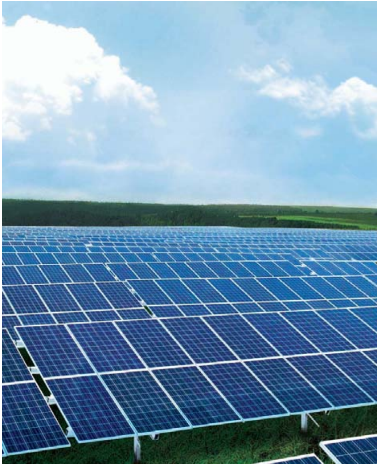
Freifläche Blankenburg, Gesamtleistung: 1,6 MW, Versorgung von 450 Haushalten, Canadian Solar CS6P 240 M 240 Wp 6.792 Stück, CO 2 -Einsparung pro Jahr: 1.380 Tonnen.
