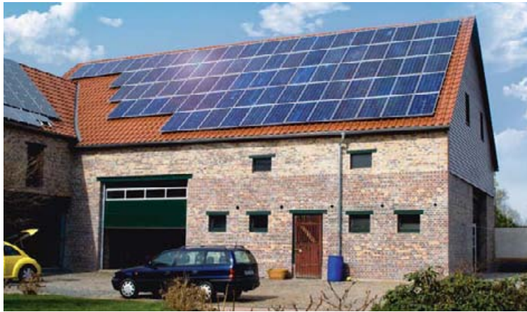
Nebengebäude, Region Borna, Polykristalline Anlage, 18 kWp, Module CS6P-220 85 Stück.
