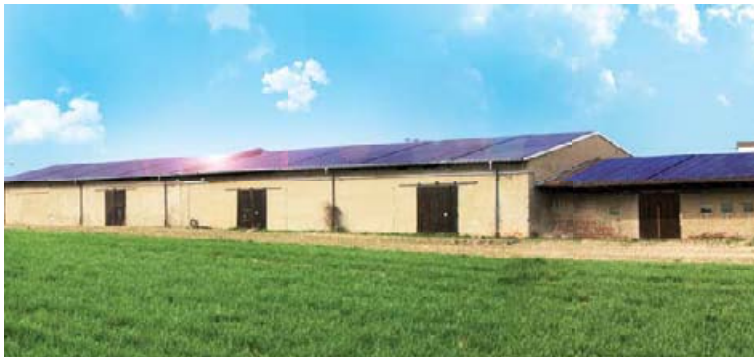
Landwirtschaftliches Objekt, Region Leipzig, Dünnschichtanlage, 215 kWp, Module FS275 2870 Stück.
